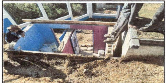
Foto 4: Sustitución de Estructura de Soporte de madera por Metal
