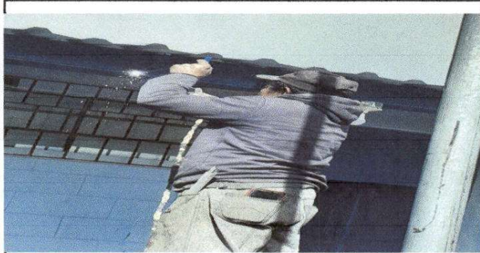
Foto 9: sustitución de soporte de metal para canal
