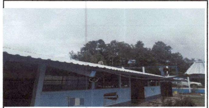
Foto 8: Sustitución de Canal de Metal
