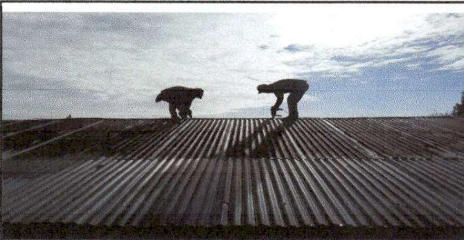
Foto 3: Sustitución de Elementos de fijación
