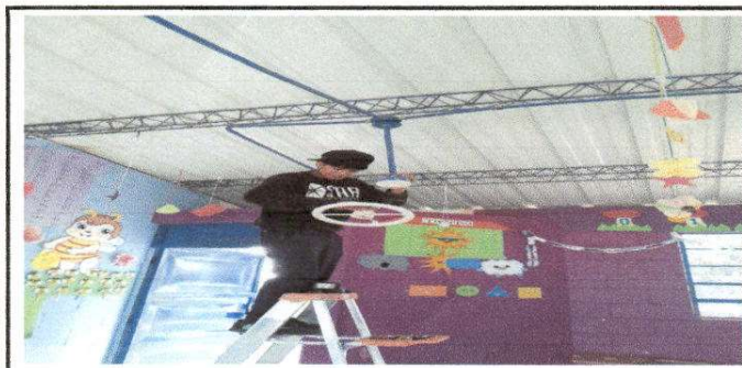
Foto 11: Reparación de Sistema electrico
