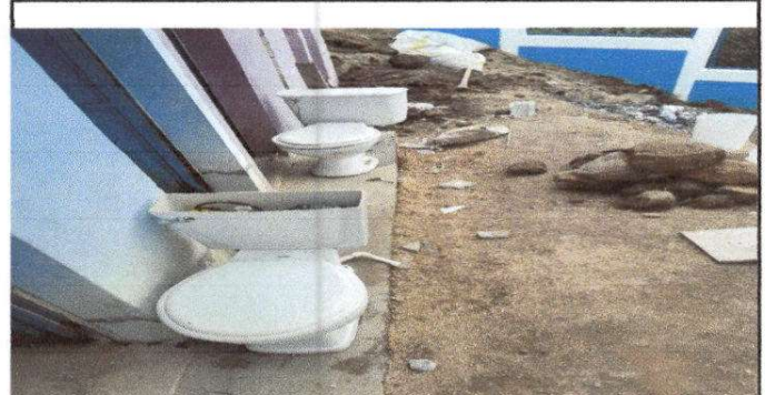
Foto 10: sustitución de inodoros
